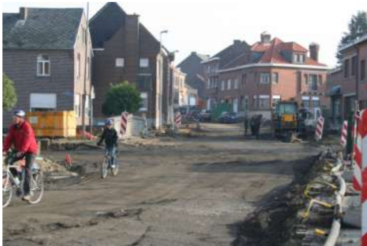
Figuur 182. Werken aan Stationstraat
