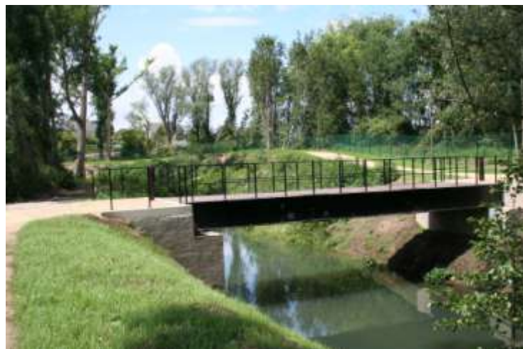
Figuur 171. De nieuwe brug is af
