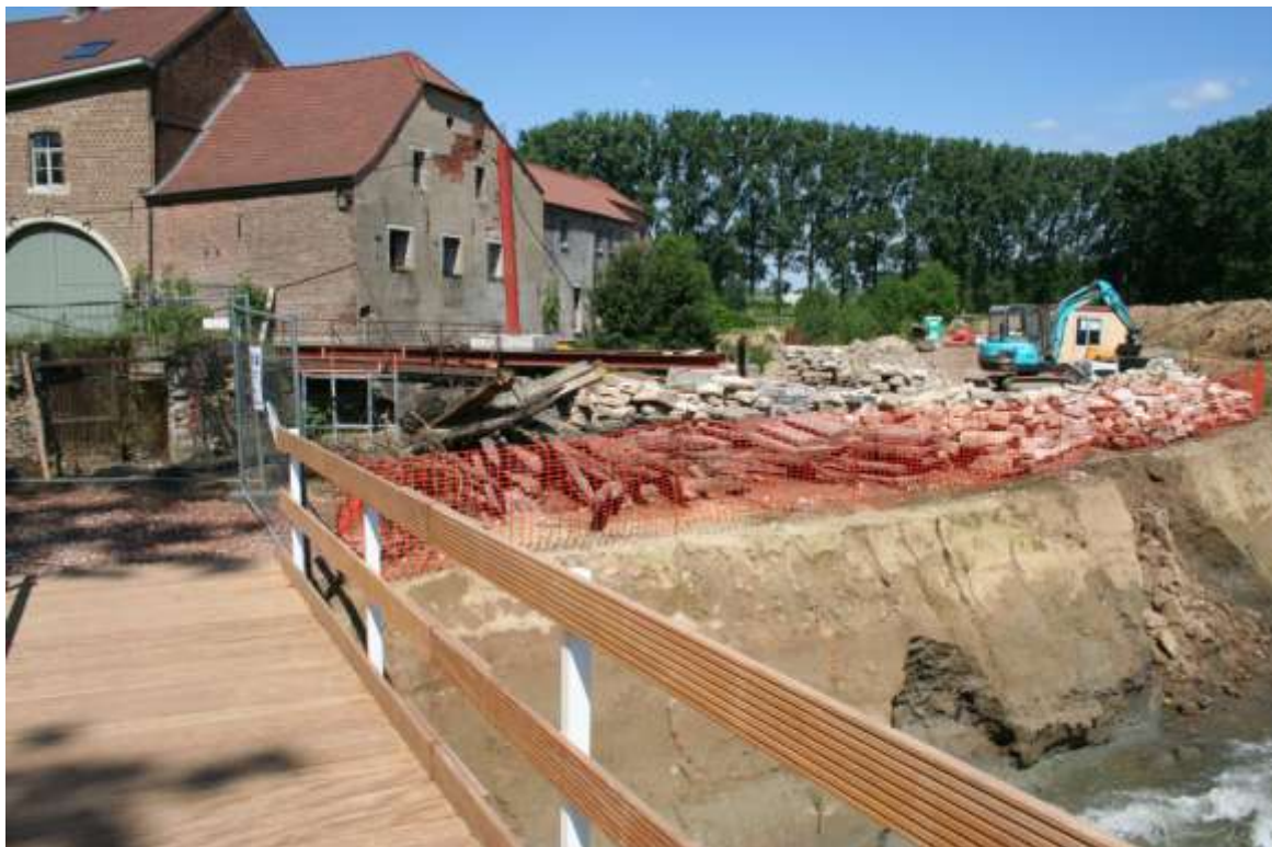
Figuur 150. De Gete wordt omgelegd en er komt een tijdelijke brug
