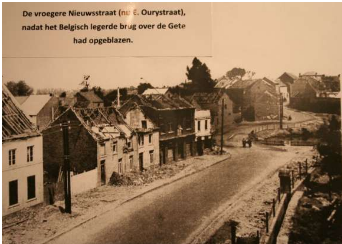
Figuur 10. Na de vernieling van de brug in de Nieuwstraat (Collectie Cipers)
